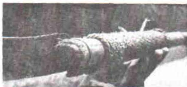
Vista del trozo de madera hincado en el bambú.
