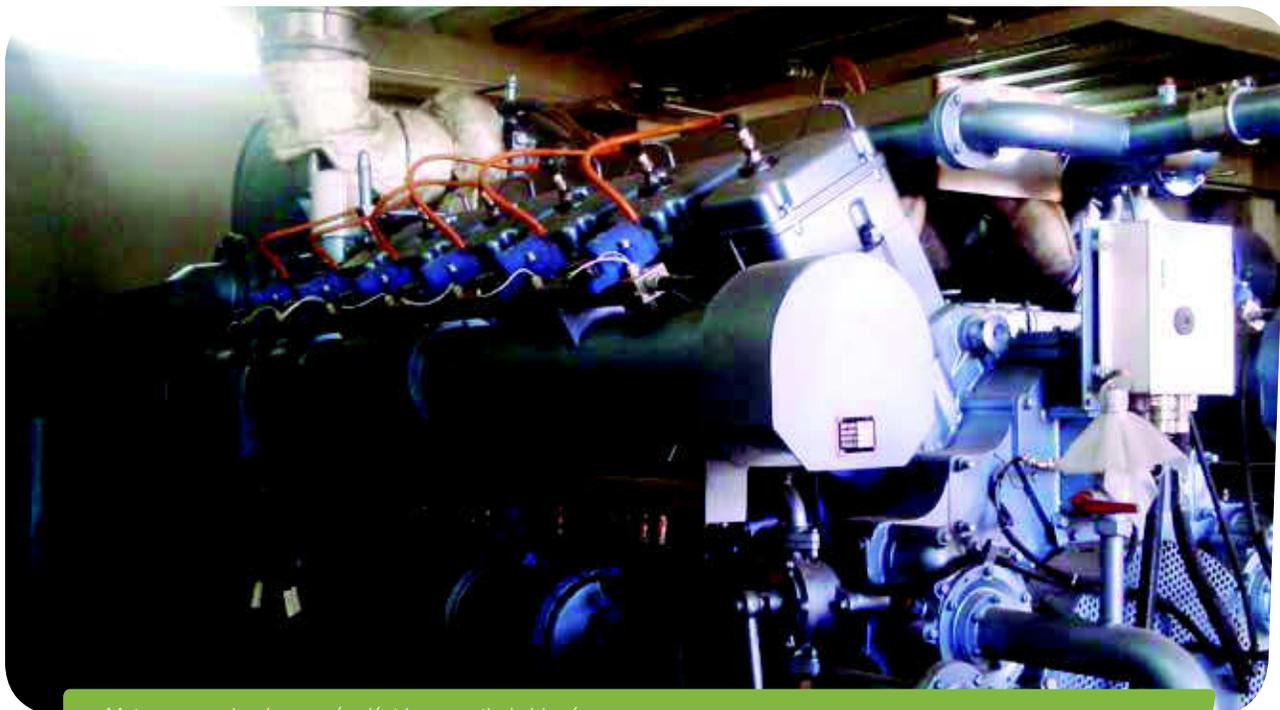
Motor generador de energía eléctrica a partir de biogás
