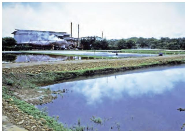
Las actuales lagunas de tratamiento de efluentes de las plantas de beneficio se convertirán en digestores anaeróbicos cubiertos, donde el gas metano producido será capturado para luego ser quemado cumpliendo con los requisitos establecidos por las Naciones Unidas. Foto: Mazorra, M.A. q.e.p.d. (2001) Palmeiras, Colección fotográfica Fedepalma.
