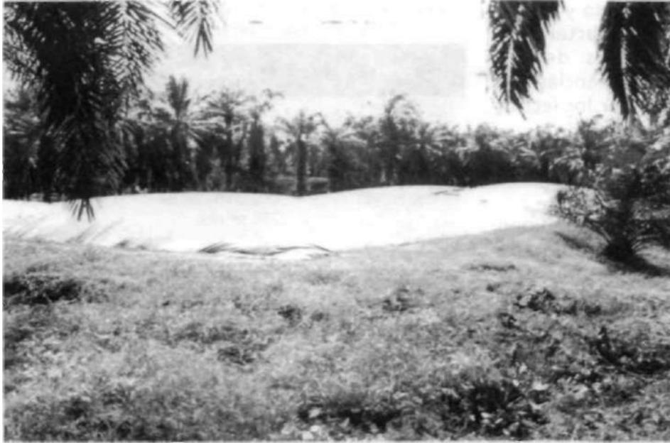
Figura 2. Laguna anaerobia carpada utilizada en la plantación Palmeiras para el tratamiento de los efluentes. Tumaco, Colombia.
