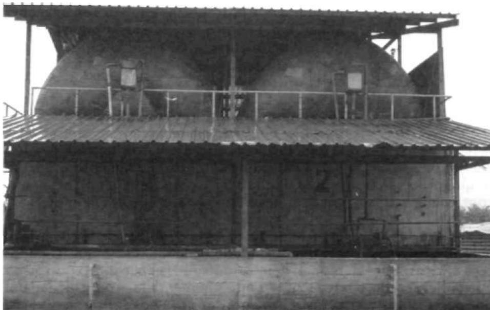
Figura 1. Biodigestores utilizados para el tratamiento de efluentes en la planta extractora de aceite de palma Palmar Santa Elena, Tumaco, Colombia.
