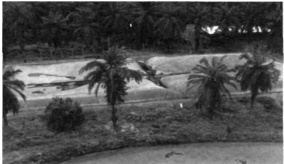
Fotografía de la laguna cubierta para recuperar el gas (Palmeiras).
