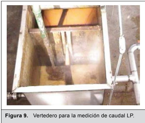
**Figura 9.** Vertedero para la medición de caudal LP.
