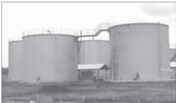
Foto 2. La digestión anaeróbica de POME produce metano.
