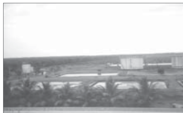
Foto 1. Los efluentes de la planta de beneficio son usados en lagunas, tanques de digestores, aplicación en el campo, compostaje y vías de agua.
