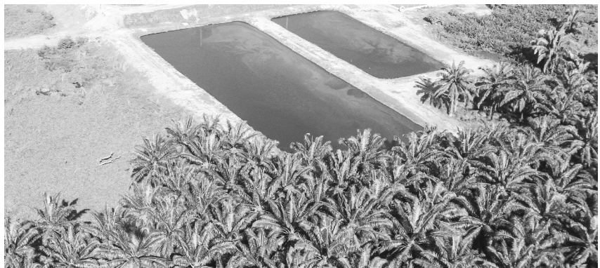
Figura 1. Sistema de lagunas abiertas para almacenamiento de efluentes.
