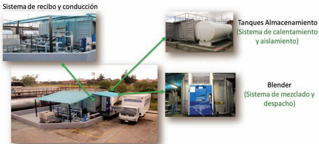
Figura 2. Estación de almacenamiento y mezcla de combustible diésel - biodiésel de palma.
