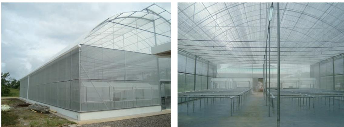
**Figura 1.** Casa de mallas para aclimatación y endurecimiento de clones en el CEPV.
