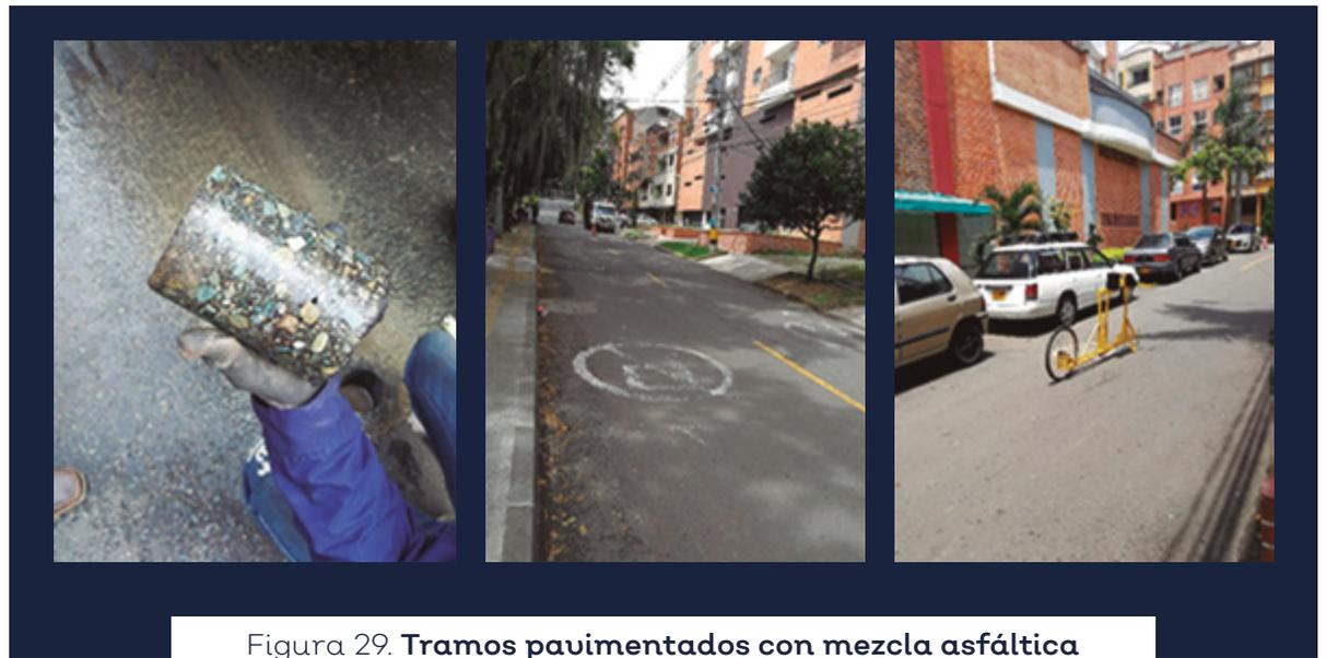
Figura 29. **Tramos pavimentados con mezcla asfáltica aditivada con aceite de palma crudo**
