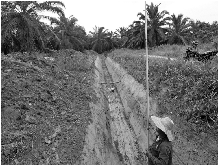
Figura 31. Mejoramiento canal principal (Lote 2, CEPV)
