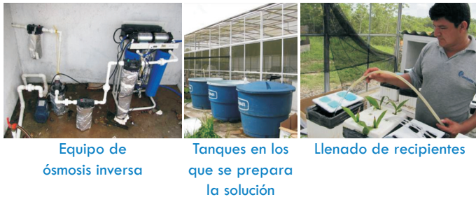
Figura 6. Elementos del sistema de alimentación de la solución nutritiva.
