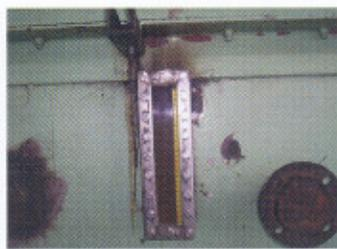
Figura 3. Disposición de la mirilla en el tanque de aceite crudo
