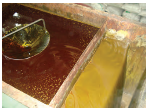
Figura 16. Separación de las fases de aceite y lodos parte interna del preclarificador.
