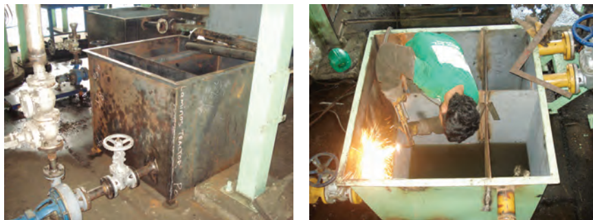
Figura 23. Tanques de bombeo de lodos expreclarificados.
