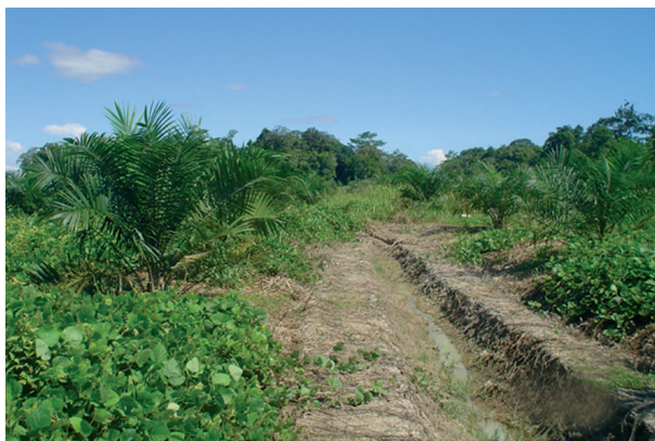
Figura 5. En esta plantación se ha construido un sistema de drenaje que permite evacuar oportunamente los excesos de agua superficial y la interna contenida en el suelo; brindar mejores condiciones para el desarrollo satisfactorio de las palmas y reducir los riesgos de que se presente la PC.
